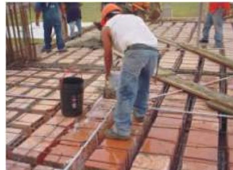
El vaciado de la losa comienza con el llenado de las viguetas para continuar con el vaciado de 5cm de mezcla sobre la losa. Durante el vaciado del concreto para la losa, el espesor del concreto debe ser verificado mediante el reglado (enrasado) para conseguir el nivel en cada sector.
