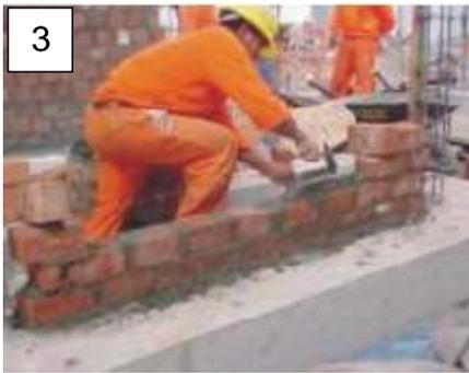
Usando el badilejo se coloca la mezcla sobre los ladrillos de manera que penetre en la junta entre ladrillos.
