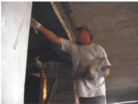
Para el acabado de los muros y la superficie interna de los techos es necesario el uso de andamios, de manera que el tarrajeo del acabado de los elementos puede realizarse en altura. Se inicia desde la parte superior y continúa hacia la parte inferior. La mezcla en volumen es de una relación cemento arena de 1 en 3.
