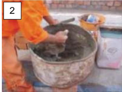
La mezcla de arena y cemento debe hacerse en seco. Luego esta mezcla se coloca en el recipiente para agregar el agua y lograr una mezcla trabajable.
