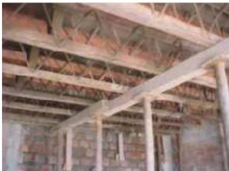
Si se utilizan encofrados de madera, las planchas deben ser humedecidas antes de colocar el concreto, igual que los ladrillos de techo. Debe de tomarse un especial cuidado en los niveles de los encofrados. Sólo una pequeña deformación de las planchas o tablas de encofrado podría ocasionar flexiones de los elementos. Se debe revisar la longitud del empalme de las barras de acuerdo con su diámetro. La longitud del empalme debe ser mayor que 20 veces el diámetro de la barra.
