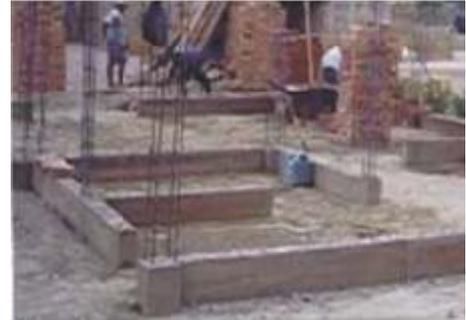
Se recomienda el uso de una mezcla cemento, arena y hormigón para el sobrecimiento de: 1:8 más 30% de piedra mediana. Debe usarse vibrador a fin de lograr una buena uniformidad en la mezcla.
