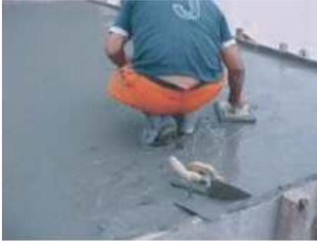
Terminado el vaciado se utiliza una plancha o un badilejo pasando suavemente en la superficie dando un mejor acabado al piso.
