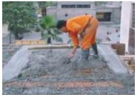
Una manera de hacer esta nivelación es el colocar tablas o reglas en los extremos para luego llenar los espacios vacíos, enrasando como se observa en la foto. Este procedimiento se repite de lado a lado sucesivamente hasta terminar el vaciado de la losa.
