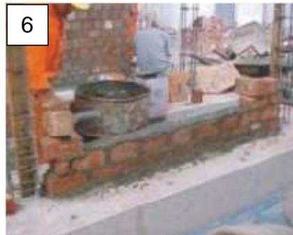
Con la ayuda del escantillón y un cordel amarrado entre los dos extremos se verifica la altura de cada hilada, incluyendo el espesor de la junta. Así, los dos ladrillos maestros tienen la misma altura y alineación para que los otros ladrillos a ser asentados tengan también el mismo espesor de junta.
