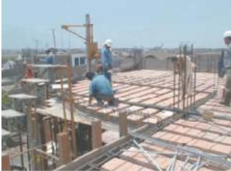
Para elementos de concreto (columnas, vigas, escalera y losas) los refuerzos son varillas de acero corrugado cortadas en longitud apropiada. Teniendo todos los muros construidos y la habilitación de refuerzo de las vigas listas, se hace el encofrado del techo. Se debe de tomar en cuenta los debidos anclajes y traslapes en el armado del elemento de concreto armado, así como sus recubrimientos correspondientes (ver tabla abajo).
