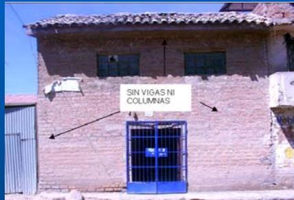
Albañilería sin ningún arriostramiento ni confinamiento de muros
