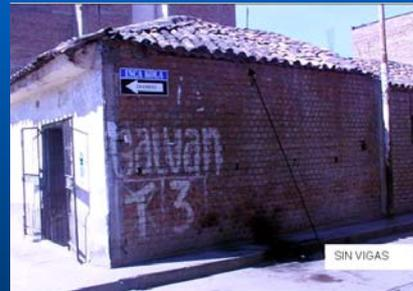
Albañilería con columnas pero sin vigas de confinamiento
