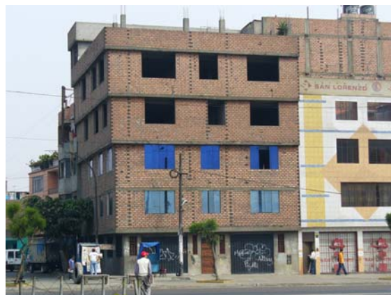
Figura 1. Construcciones de 2 a 4 pisos con ladrillo pandereta.
