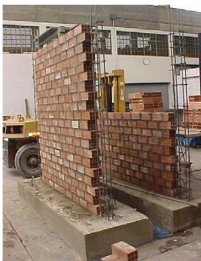
Figura 9. Construcción de los muros.
