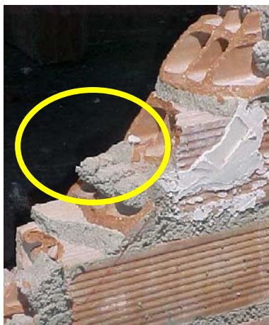
Figura 8. Detalle. Nótese las llaves de mortero en los agujeros de los bordes de la unidad.
