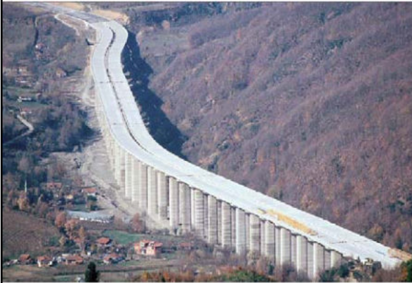
Viaducto Bolu (FP)
