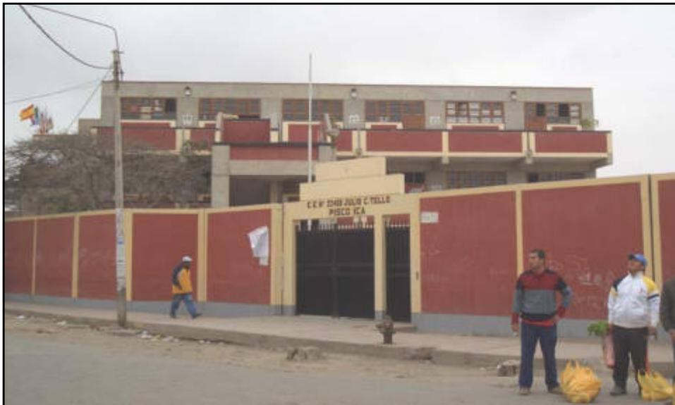
Centro Educativo seguro diseñado con la Norma Sismoresistente de 1997 / 2003. Note los muros de concreto armado en la dirección flexible y que ellos están separados de los muros bajos en 2cm.
