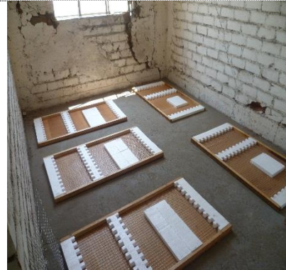
Foto 88. Colocación de encofrados para muros
