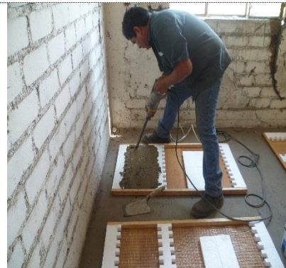
Foto 90. Vibrado de mezcla en los muros
