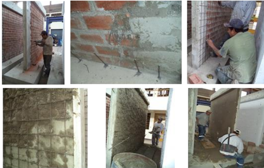
Figura 4. Construcción de los muros reforzados con la técnica propuesta
