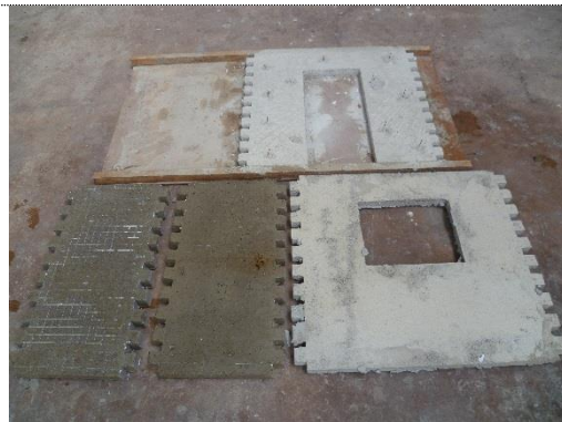
Foto 96. Vista posterior de muros de módulo con reforzamiento total
