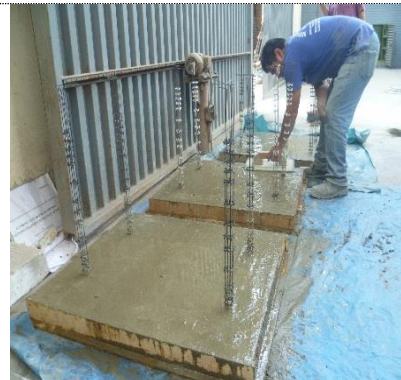
Foto 102. Nivelación de las bases de concreto
