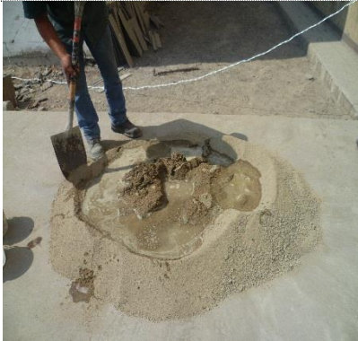
Foto 87. Preparación del mortero 1:8 para el vaciado de los muros
