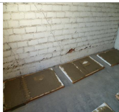
Foto 92. Secado de muros
