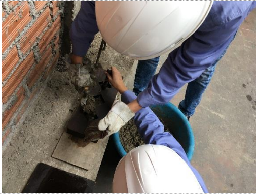
Foto 33. Vaciado de la mezcla de mortero en 3 capas
