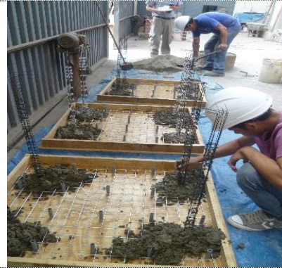
Foto 100. Compactación en zona de columnas
