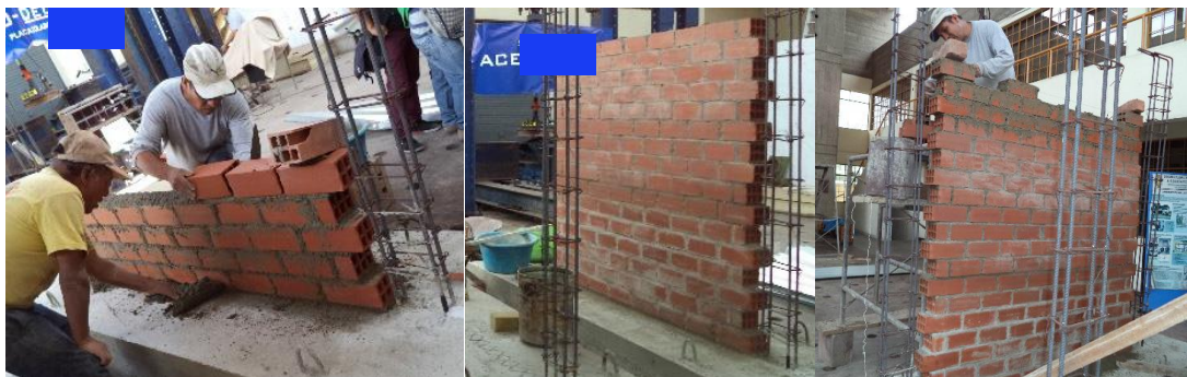
Figura 3. Construcción de los muros de albañilería confinada
