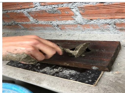
Foto 6. Vaciado de la mezcla en los moldes para cubos
