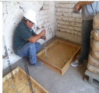
Foto 98. Colocación de la malla y fijación de las columnas en la base
