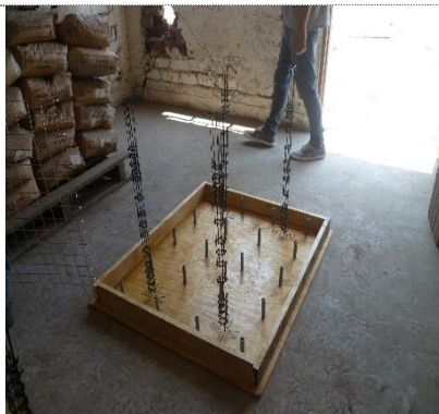
Foto 97. Encofrado para base de concreto
