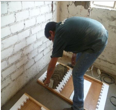
Foto 89 Vaciado del mortero para muros
