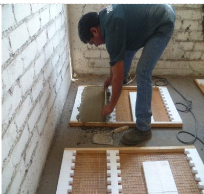
Foto 91. Enrasado de la mezcla en muros
