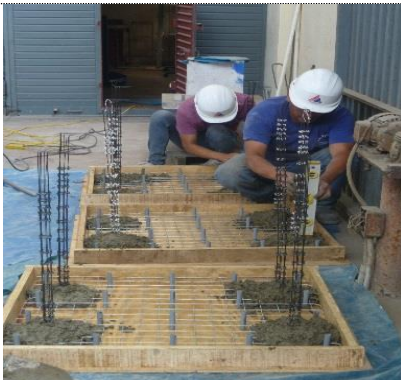
Foto 101. Aplomando de columnas para mantener su verticalidad
