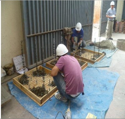
Foto 99. Vaciado del concreto para asegurar la armadura de columnas
