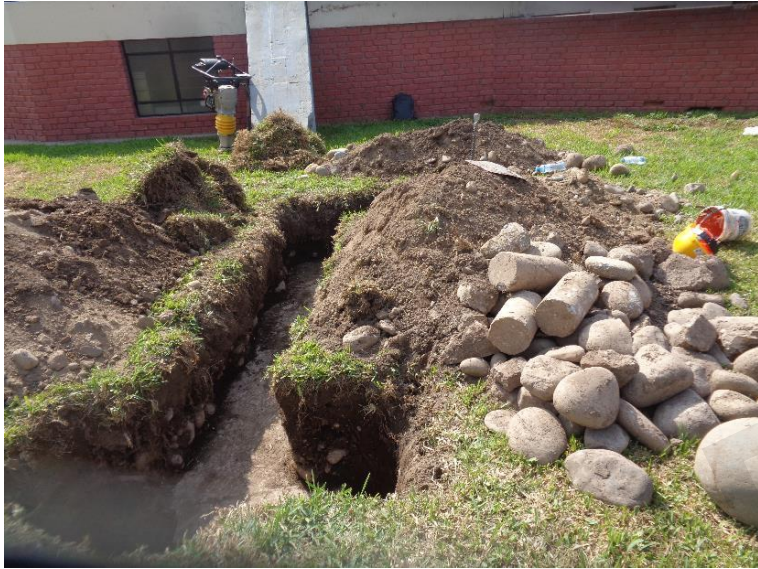
Auscultación de cimentación
