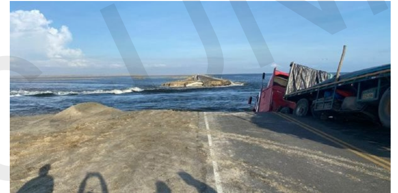
Tramo de Carretera desplazado por la crecida de la laguna. 21 de marzo del 2023. Fuente: RPP Noticias.
