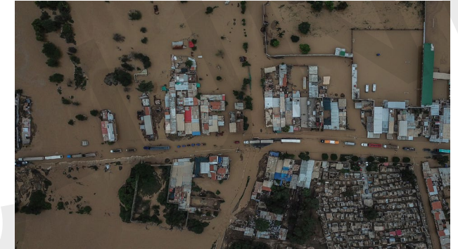
Inundación de viviendas. 13 de marzo del 2023. Fuente: Mejía A.
