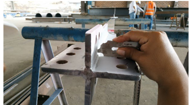
Verificación de la soldadura
