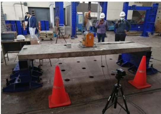
Ensayo Losas Acero Deck
