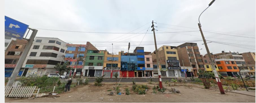
Sistema estructural más empleado en Lima Metropolitana: Albañilería confinada
