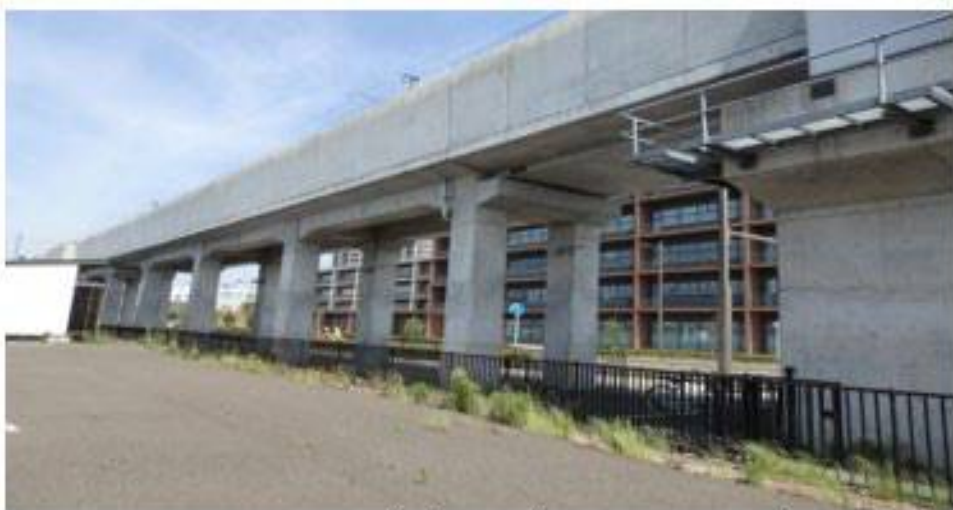
F-3AA5. Puente con aisladores sísmicos. Parte baja de la ciudad de Sendai. Foto mayo 2016.
