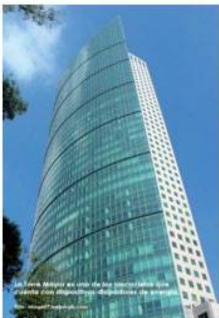
F-3AA7. Torre Mayor. Santiago de Chile. Con sistemas de disipación de energía, sin daños el 27 Feb. de 2010.
