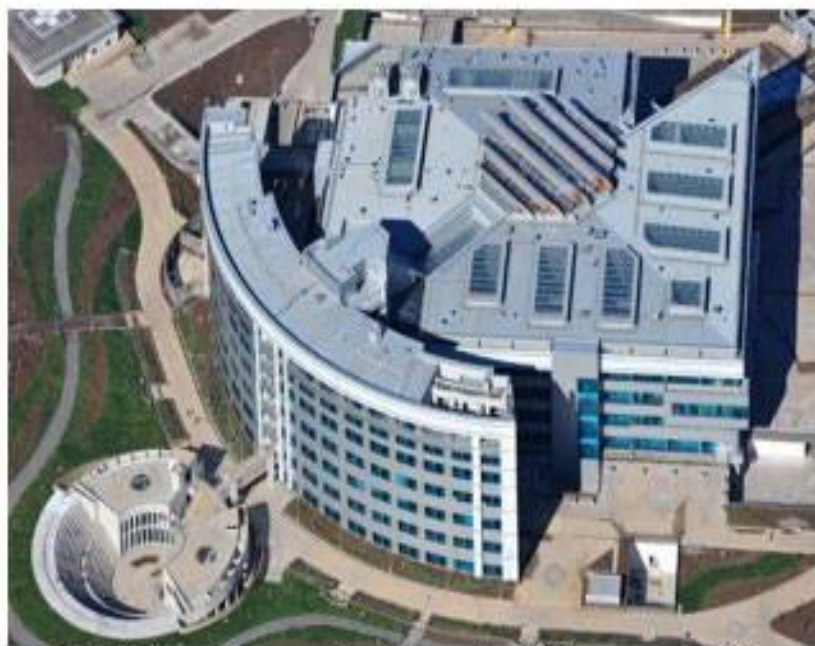
F-3AA8. Hospital en Santiago de Chile con aisladores sísmicos. Fuente: Internet.
